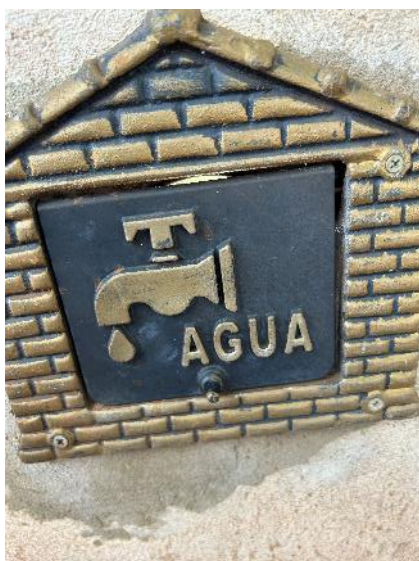
Figura 24: Abrigos de hidrômetros no município de Barrinha/SP.
